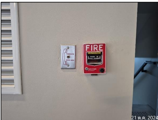
ภาพที่ 23 อุปกรณ์แจ้งเหตุเพลิงไหม้ด้วยมือ
